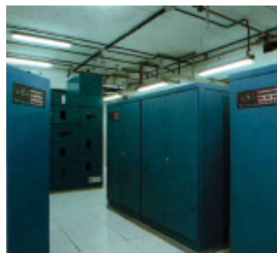
Система с резервированием шины питания нагрузки (LBR)
